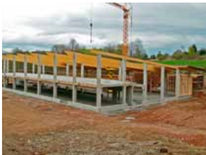
Haupttragwerk: Gabelgelagerte Brettschichtholzträger auf Stahlbetonstützen
