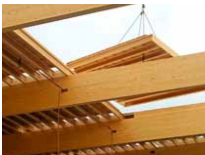
Die fertigen Elemente wurden per Kran passgenau platziert.
