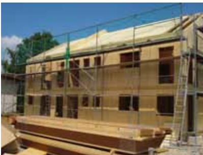
Fertig abgebundene STEICOjoist Dachsparren warten auf die Montage am Dach.
