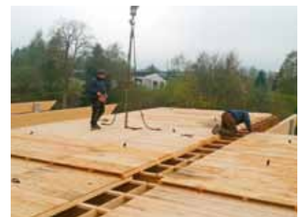
Zimmermannsmäßige Verbindung der Dachelemente über Montageöffnungen
